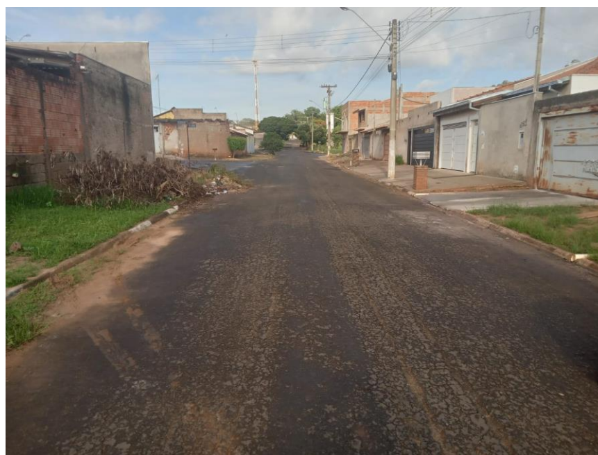
FOTO 02 – RUA ARLINDO SPIRLANDELLI, BAIRRO RES. ANDRE FRANCO MONTOURO
