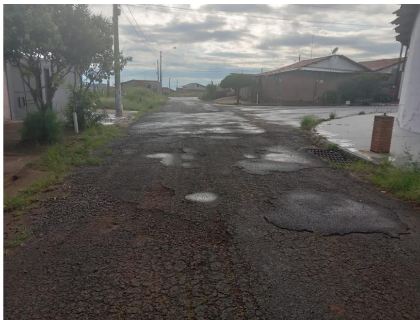
FOTO 01 – RUA ARLINDO SPIRLANDELLI, BAIRRO RES. ANDRE FRANCO MONTOURO
