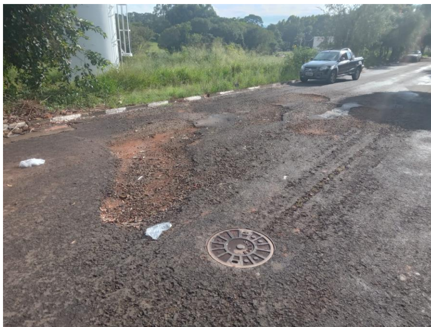
FOTO 04 – RUA ARLINDO SPIRLANDELLI, BAIRRO RES. ANDRE FRANCO MONTOURO
